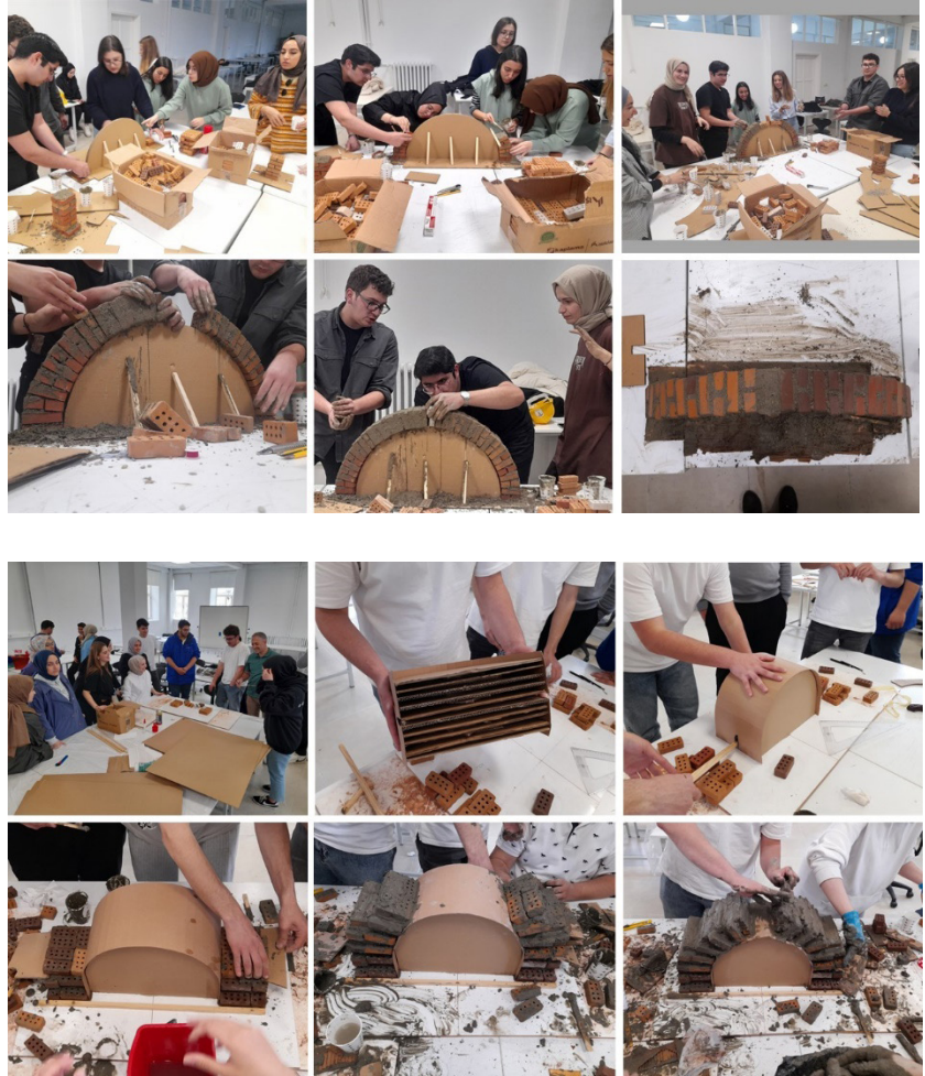
Şekil 6. İlk kemerin yapım aşamaları.
