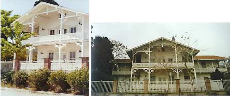
Şekil: 12 Gebze Osman Hamdi Bey Evi onarım öncesi ve sonrası (IRAM Arşivi, 1986; Billur 2020, 156 ve 158).
