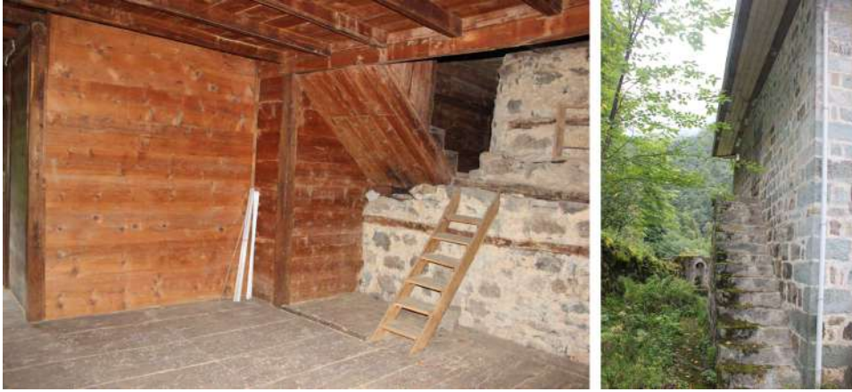
Şekil: 22 Otluk mekanına ulaşımı sağlayan ahşap ve taş merdivenler.
