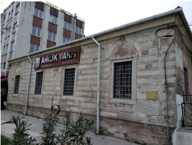
Şekil: 17 Kara (Gazi) Ahmet Paşa Sıbyan Mektebi Güney Cephesi ve İç Mekânı (Balcan 2018).
