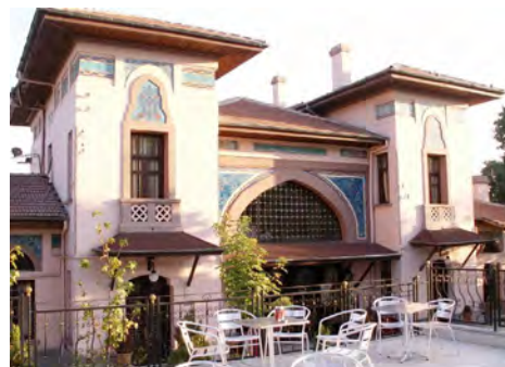
Şekil: 2 Ankara Gazi Tren İstasyonu Yolcu Binası (Yıldız 2008, 123).
