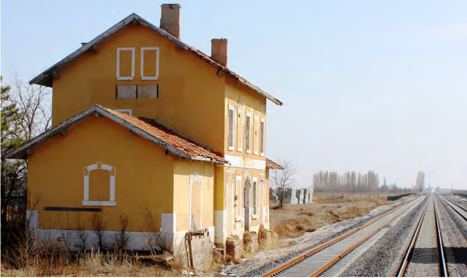
Şekil: 1 Kullanım Dışı Kalan Demiryurt İstasyonu Yolcu Binası ve Emtia Ambarı, 2017.
