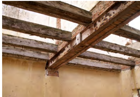
Şekil: 47 Yolcu Binası Zemin Kat Tavan Döşeme Kirişlerinin Taşıldığı Çelik Profiller, 2017.
