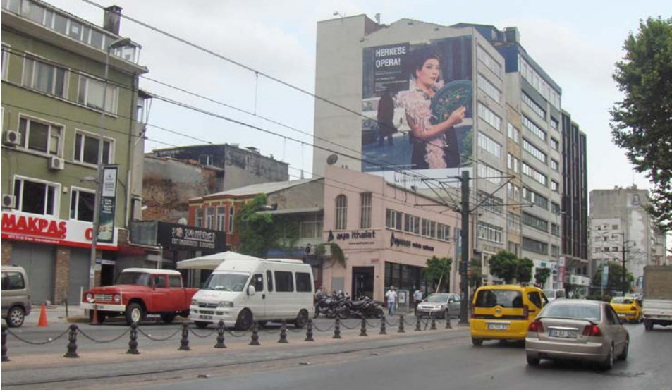
Şekil: 16 Kemeraltı Caddesi üzerinde bulunan, istimlakler sırasında cephesinin bir kısmı kesilmiş ve yeniden yapılmış yapı (Küçük, 2012).
